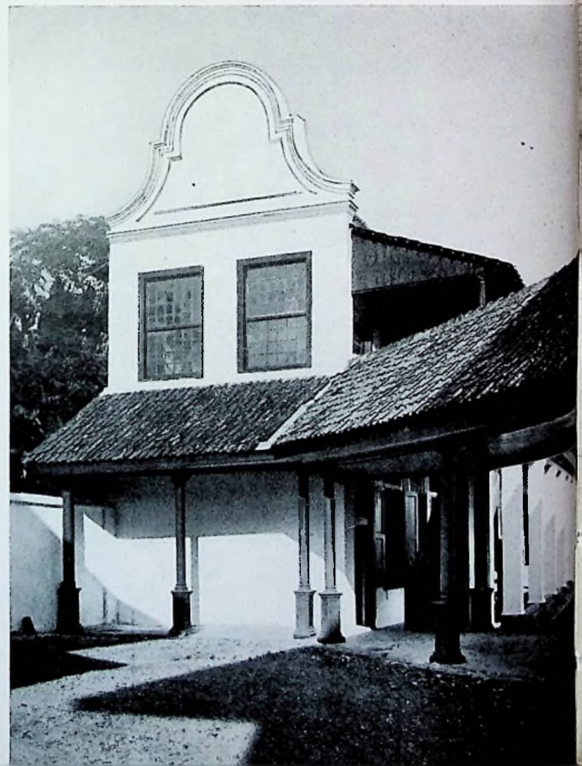
65. Voorgevel van het Zuidelijk bijgebouw
