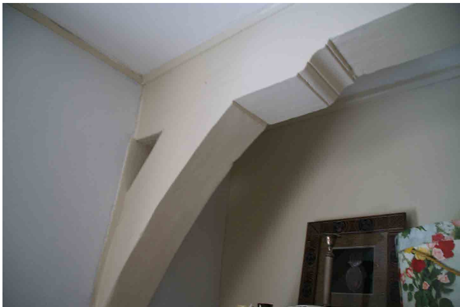
Afb. 36. Een van de weinige gebinten waarvan het korbeel bewaard bleef (het tweede gebint van voren gerekend). Foto auteur.
