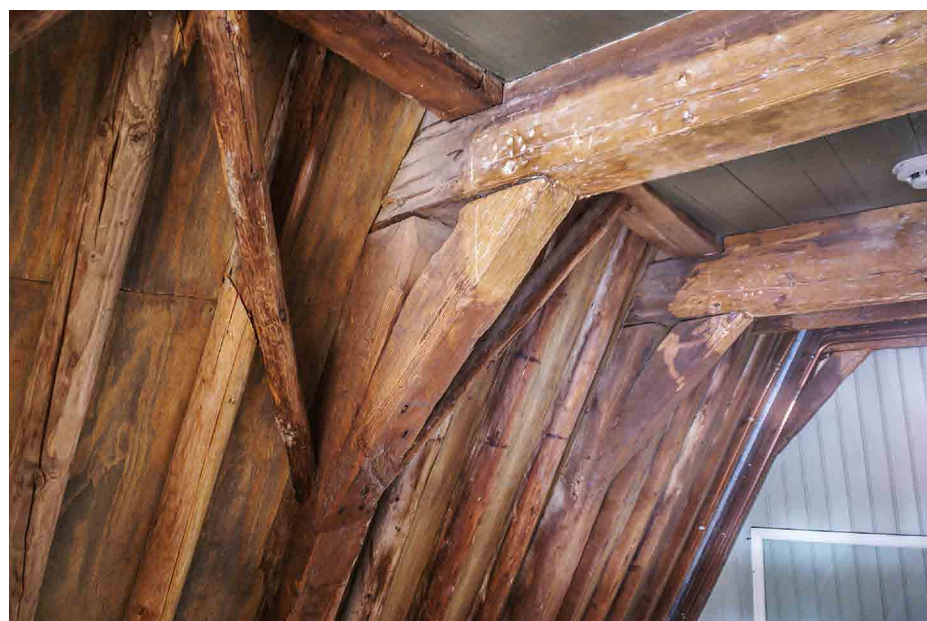
Afb. 37. De jukken op de zolder, gezien in de richting van de achtergevel. Ingekast in de dekbalken loopt het worm, dat de sparren ondersteund. Foto auteur.
