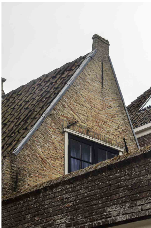
Afb. 43. De geveltop van de keukenuitbouw. Foto auteur.
