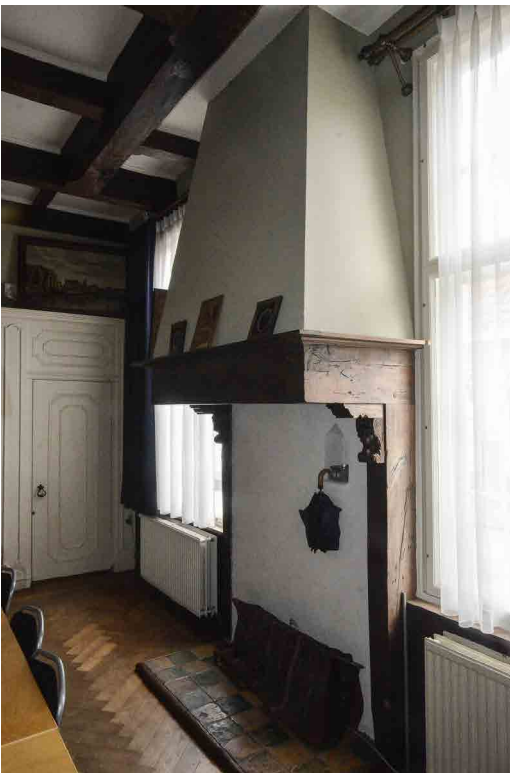
Afb. 32. In de tijd van de arts Hesselink na 1929 kwam op de plaats, waar voorheen een venster zat, een gereconstrueerde haard. Op deze plaats zat vermoedelijk, afgaande op de raveling op de verdieping en op de zolder, al eens eerder een schoorsteen. Foto auteur.
