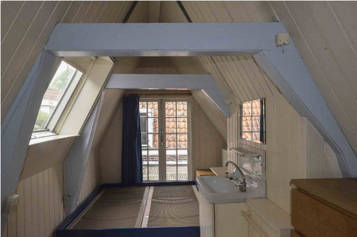
Afb. 46. De in 1933 geheel betimmerde kap van de keukenopbouw, waarin nog jukken met een kreuple stijl zijn te herkennen. Gezien in noordelijke richting. Foto auteur.
