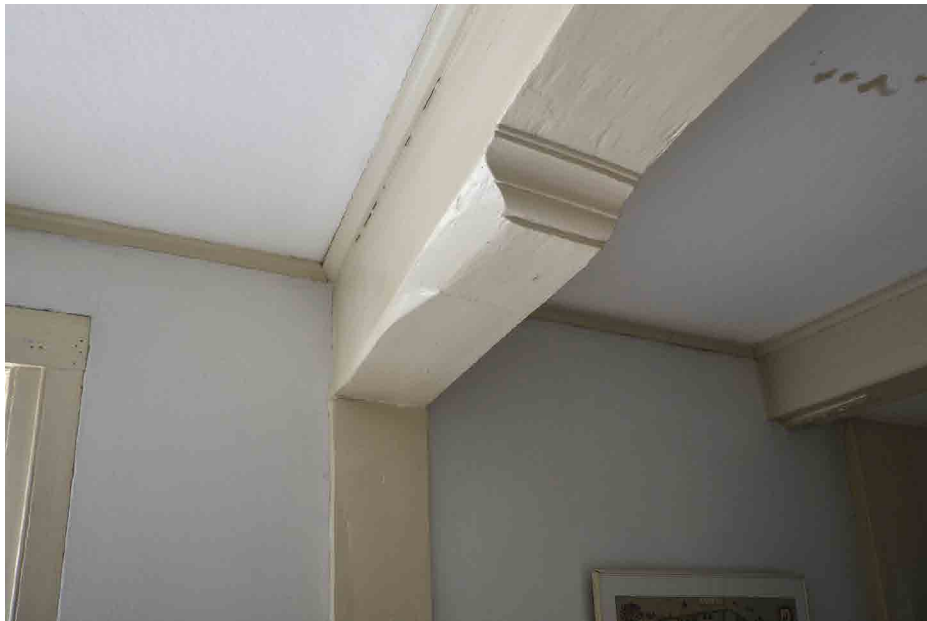
Afb. 35. Net als op de begane grond bestaat de balkenlaag boven de verdieping uit afwisselend een dekbalk van een gebint en een trek balk. Van het gebint links resteert nog wel het gesneden sleutelstuk, maar het korbeel is verwijderd. Foto auteur.
