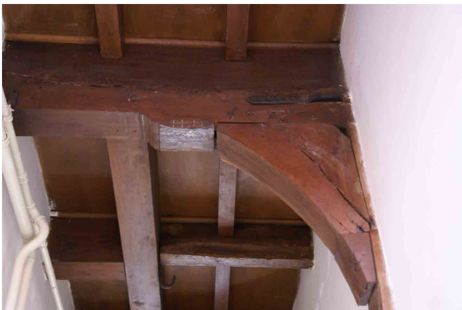
Afb. 30. Het eerste gebint, gerekend vanaf de achtergevel, heeft rechts (oostzijde) nog een muurstijl, korbbeel, gesneden sleutelstuk en dekbalk met kinderbinten. Aan de onderzijde is de baard zichtbaar van een muuranker. Foto auteur.
