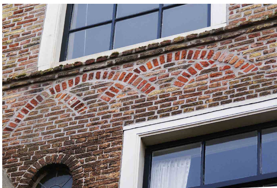
Afb. 26. De ineengevlochten ontlastingsbogen aan de achterzijde. Foto auteur.
