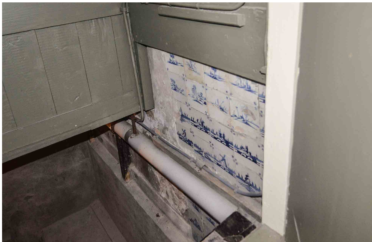
Afb. 44. De ingang van de kelder onder de keuken. Foto auteur.
