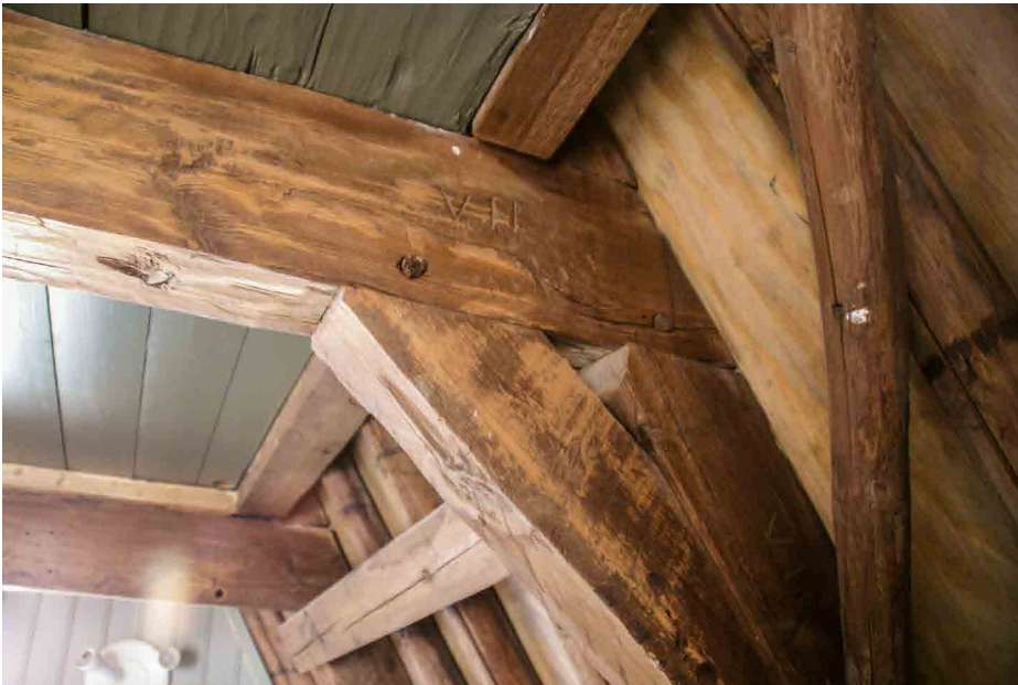
Afb. 39. De jukken op de zolder, gezien in de richting van de achtergevel. Op de voorgrond het juk met telmerk VII. Foto auteur.
