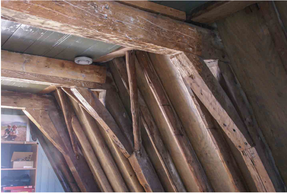
Afb. 38. De jukken op de zolder, gezien in de richting van de voorgevel. Foto auteur.
